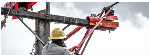
Для работ методом «на расстоянии» используются разнообразные штанги, средства коллективной защиты и прочие устройства.
