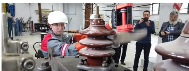
Очистка силового электрооборудования — одно из важных мероприятий бесперебойного энергоснабжения. Сухая и влажная чистка оборудования под напряжением до 35 кВ позволяет не прерывать питание абонентов. Использование специализированного оборудования исключает травматизм персонала.
